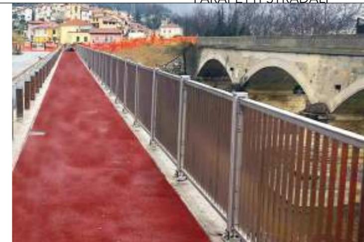
4. Il parapetto Raily PSP-X in acciaio Inox
